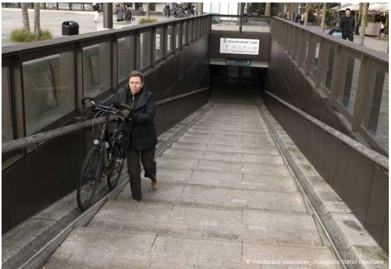
Trap-goot toegang naar ondergrondse stalling, Brugge 't Zand
